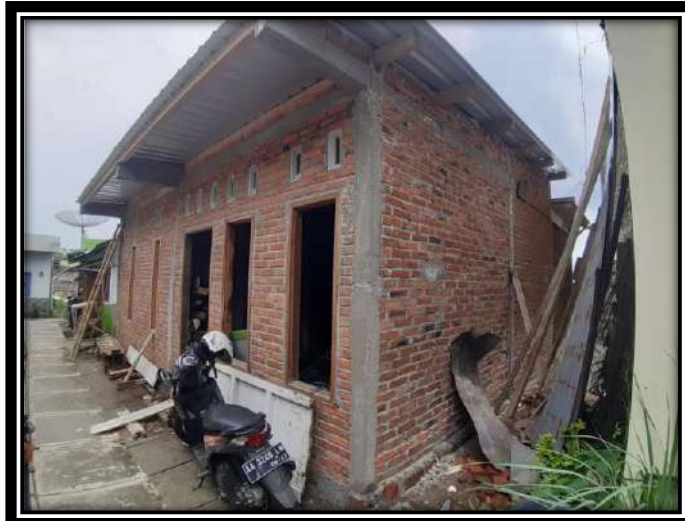
Gambar 3.5 Pembangunan Rumah Layak Huni
